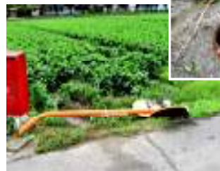
▲腐食で倒れたとみられる(24日)
